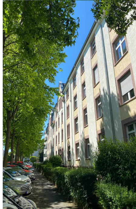
Im Lauf der Jahrzehnte hatten Setzungen die schönen Gründerzeitgebäude in der Ruprechtstraße beschädigt.
