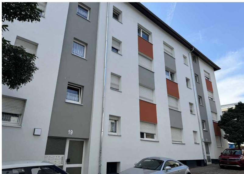
Umfassende Fassadenrenovierung in der Freihofstraße
