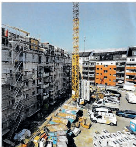
Die Liegenschaft mit elf Mehrfamilienhäusern wird um bis zu zwei Geschosse aufgestockt.
