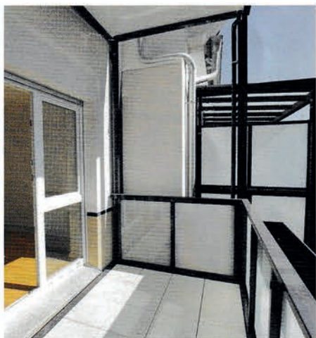
Die Balkonanlagen im Innenhof werden um weitere Balkonebenen sowie Dachterrassen ergänzt.
