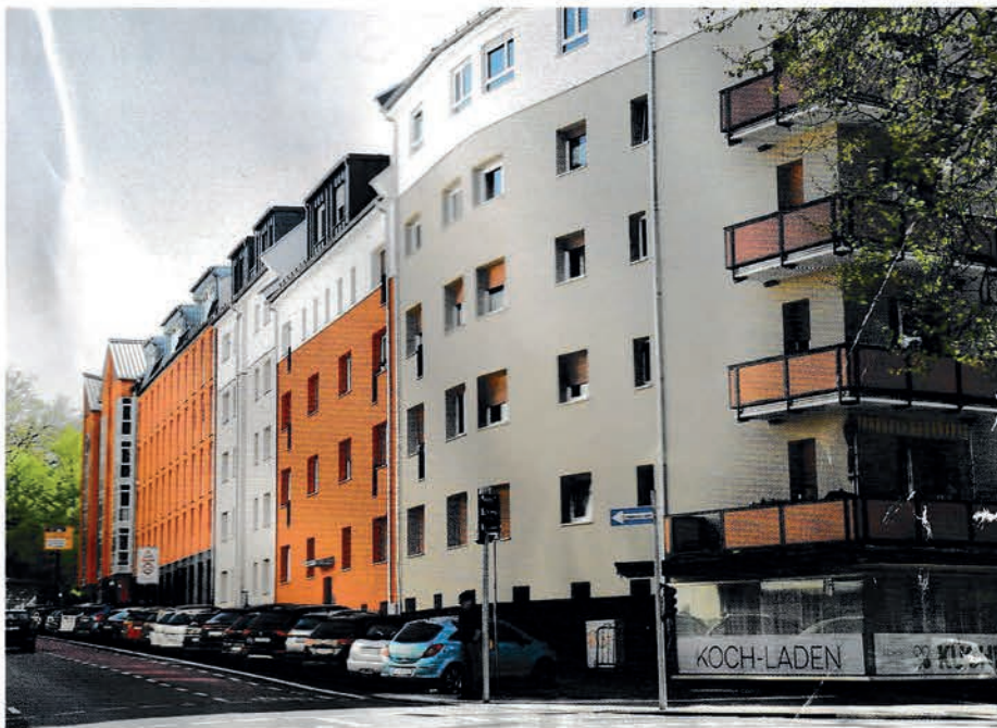
Fertigstellung des 1. Bauabschnitts: 30 neue Wohnungen in verschiedenen Größen und Schnitten sollen auf den Dächern der Gebäuderiegel im Nibelungen-Dreieck entstehen.
