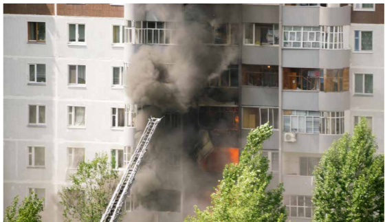
Balkonbrände verursachen oft immense Schäden.
